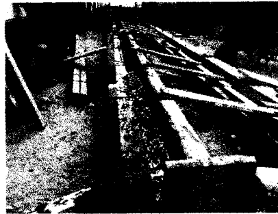
Foto 63, 64 y 65: Concreto f'c= 210 kg/cm 2 , en sardinel para la empezar la fabricación de veredas - Pavimento. PATIO MANIOBRAS
