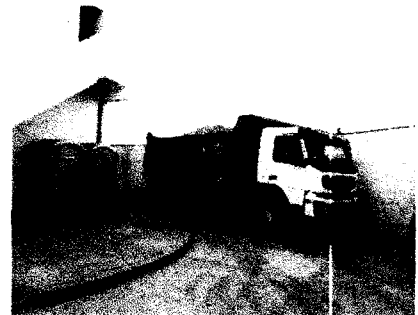
Foto 24, 25 y 26: Acarreo de material procedente de excavaciones de zona de emisor submarino, patio de maniobras, canaletas, solados, buzones, cajas, demoliciones y picados. Para luego ser eliminada con maquinaria volquete en zona libre aprobada por los moradores de dicha localidad. DPA YACILA
