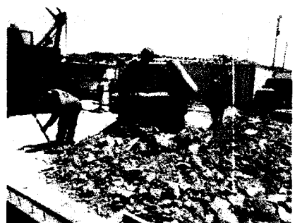
Foto 27, 28 y 29: Acarreo de material procedente de excavaciones de zona de emisor submarino, patio de maniobras, canaletas, solados, buzones, cajas, demoliciones y picados. Para luego ser eliminada con maquinaria volquete en zona libre aprobada por los moradores de dicha localidad. DPA YACILA
