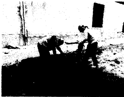
Foto 01, 02 y 03: Excavación, trazos y acarreo de terreno para ser rellenada con material afirmado y nivelado. PATIO DE MANIOBRAS.
