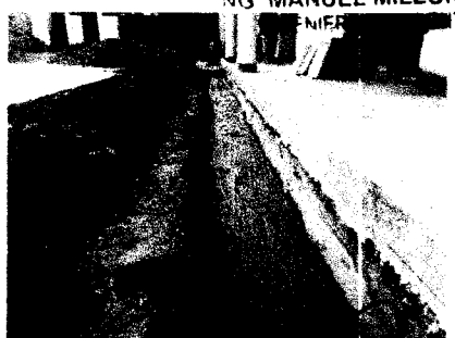
Foto 33, 34 y 35: Acero f'y= 4200 kg/cm 2 , solados y trazos, para muros de canaletas. EXTERIOR DE AREA DE ADMINISTRACION
