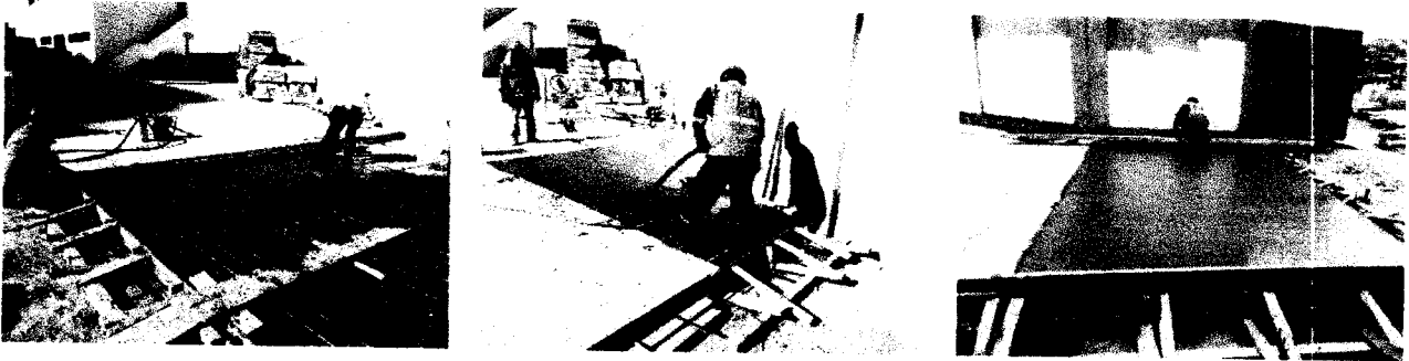
Foto 13, 14 y 15: Vaciado de concreto f'c= 315 \text{ kg/cm}^2 , en patio de maniobras. Las losas son fabricadas respetando su procedimiento constructivo y como lo manda las especificaciones técnicas. PATIO DE MNAIOBRAS
