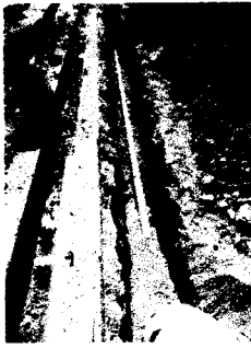
Foto 47, 48 y 49: Preparación de cama de arena y relleno de II.SS - desagüe doméstico y desagüe industrial. Esta preparación de cama de arena es para poder tender las salidas de desagüe y agua fría. PATIO DE MANIOBRAS
