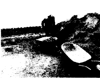
Foto 04, 05 y 06: Relleno y compactación con material afirmado y nivelación para sus respectivas pruebas de densidad de campo, liberación y armado de losas prefabricadas. PATIO DE MANIOBRAS.
