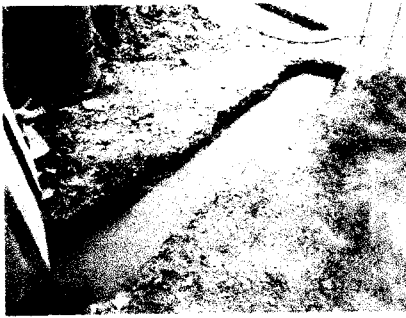
Foto 57, 58 y 59: Vaciado de Solados de concreto f'c=100 kg/cm 2 , para empezar con la fabricación del sardinel para veredas – Pavimento. PATIO MANIOBRAS
