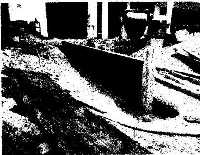
Foto 60, 61 y 62: Encofrado y desencofrado de sardinel de concreto para empezar con la fabricación veredas – Pavimento. PATIO MANIOBRAS
