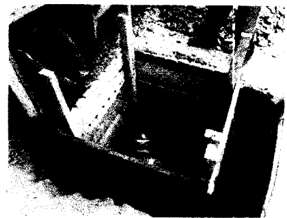
Foto 41, 42 y 43: Tarrajeos con impermeabilizante en cajas de registros, estaciones de bombeo y buzones, para las instalaciones sanitarias. PATIO DE MANIOBRAS.
