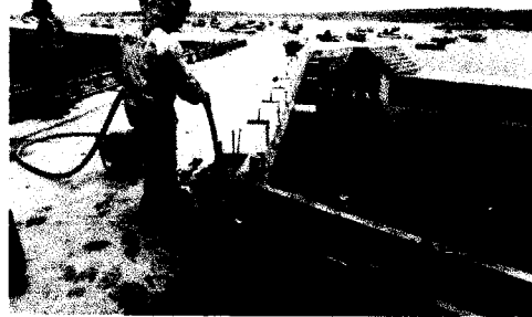
Fotografía N°05: vibrado en sardinel de puente del muelle.
