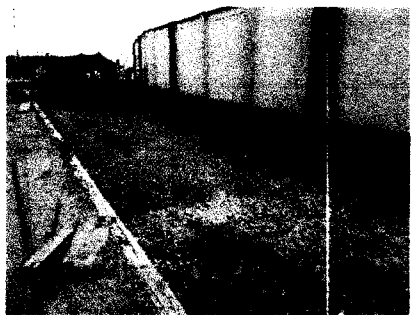
Foto 04, 05 y 06: Relleno y compactación con material afirmado y nivelación para sus respectivas pruebas de densidad de campo, liberación y armado de losas prefabricadas. PATIO DE MANIOBRAS.
