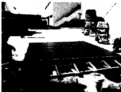
Foto 10, 11 y 12: Vaciado de concreto f'c=315 \text{ kg/cm}^2 , en patio de maniobras. Algunas losas que van pegadas al cerco perimétrico tienen que ir con juntas. PATIO DE MANIOBRAS.
