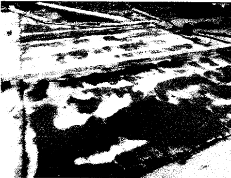
Fotografía N°08: curado de losas.
