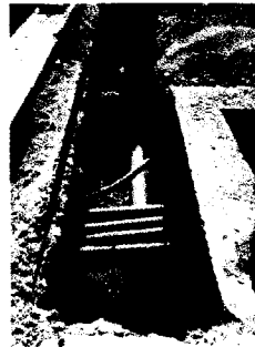
Foto 52, 53 y 54: Trazos y replanteos, Nivelación de tuberías, para instalaciones sanitarias. PATIO DE MANIOBRAS-VEREDAS
