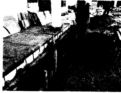
Foto 36 y 37: Concreto f'c=210 kg/cm 2 , encofrado y desencofrado, para muros de canaletas. EXTERIOR DE AREA DE ADMINISTRACION
