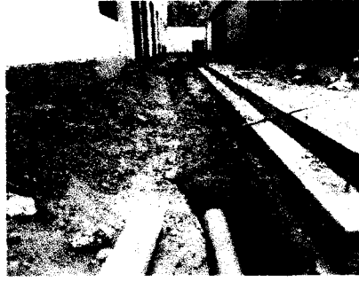
Foto 47, 48 y 49: Preparación de cama de arena y relleno de II.SS - desagüe doméstico y desagüe industrial. Esta preparación de cama de arena es para poder tender las salidas de desagüe y agua fría. PATIO DE MANIOBRAS
