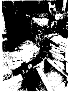
Foto 60, 61 y 62: Encofrado y desencofrado de sardinel de concreto para empezar con la fabricación veredas – Pavimento. PATIO MANIOBRAS
