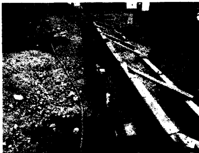
Foto 63, 64 y 65: Concreto f'c= 210 kg/cm 2 , en sardinel para la empezar la fabricación de veredas - Pavimento. PATIO MANIOBRAS
