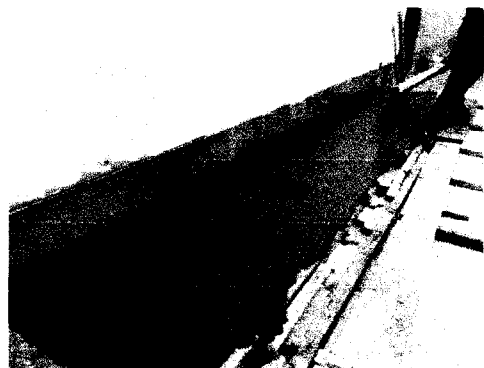
Fotografía N°10: vaciado de veredas en área de almacén.
