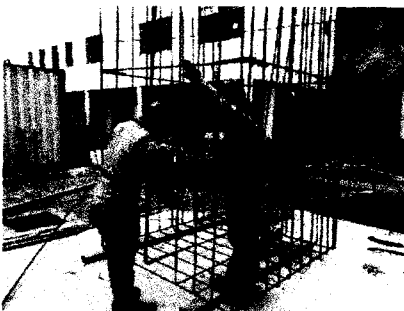
Foto 44, 45 y 46: Acero de refuerzo para instalaciones sanitarias (Cajas de lodos, cajas de registros, estaciones de bombeos) en muros y losa maciza – Concreto Armado. PATIO DE MANIOBRAS.
