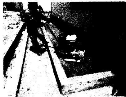
Foto 66, 67 y 68: Relleno con material afirmado, compactado y nivelación de área para el vaciado de veredas - Pavimento. PATIO MANIOBRAS – EXTERIOR DE AREA DE ALMACEN
